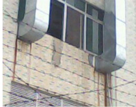
• Pic 13 工厂大楼外景
