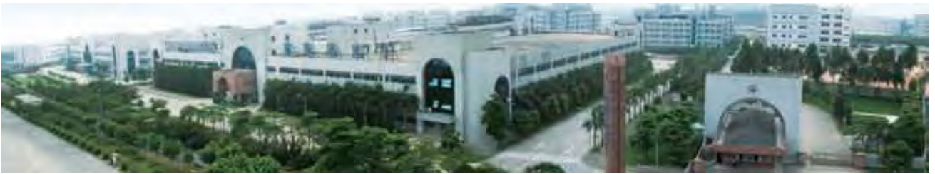
恩斯迈电子（深圳）有限公司全貌
